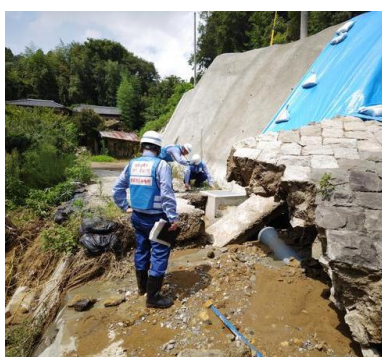
道路法面の被災状況調査 (千葉市)
