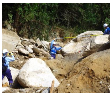
土砂災害被害状況の調査
