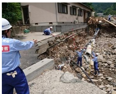
河川被害状況の調査
