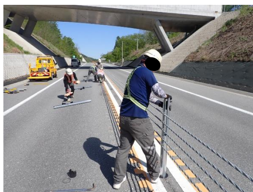
ワイヤーロープ式防護柵補修
