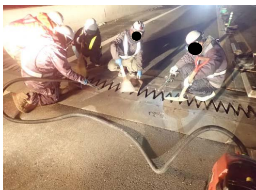
橋梁維持修繕工事
