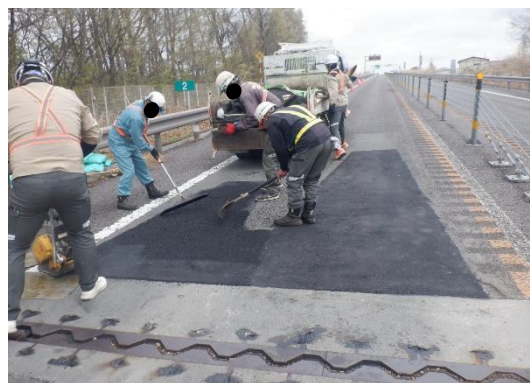
路面補修工事
