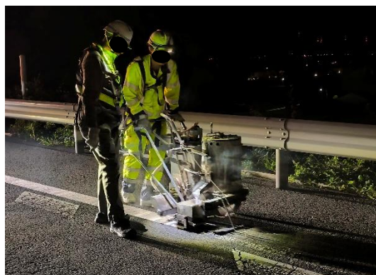
区画線引き直し工事
