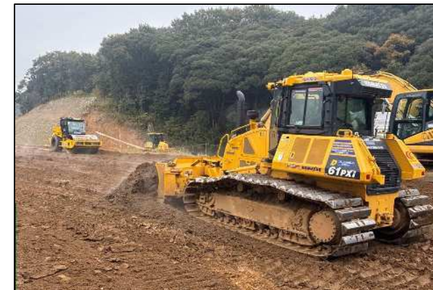
重機による盛土敷均し転圧状況
