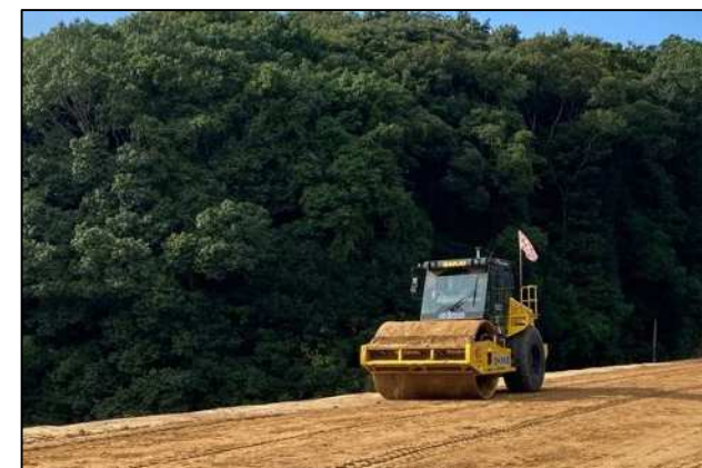
重機による盛土転圧状況
