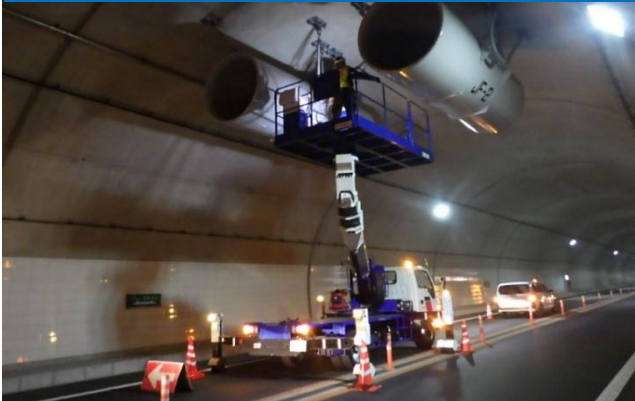
高所作業車によるトンネル設備点検のイメージ写真 中部横断自動車道の点検時の写真です。
