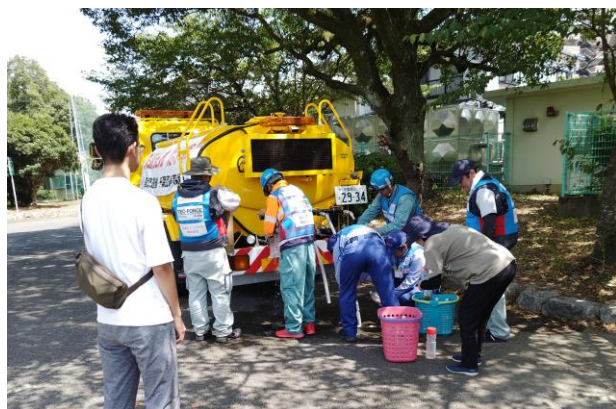
現地での配水支援作業
