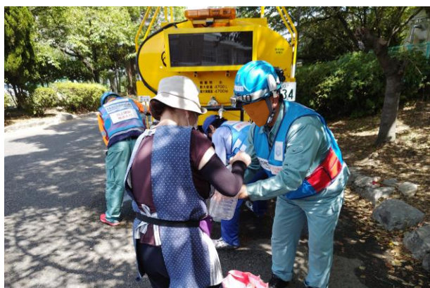
現地での配水支援作業
