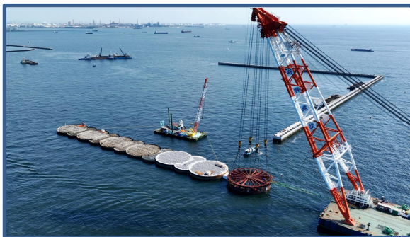
鋼板セル据付
