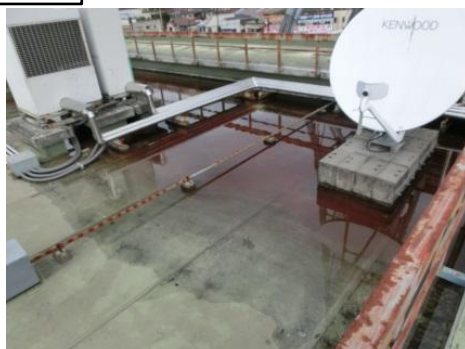
撤去箇所（防水改修）
