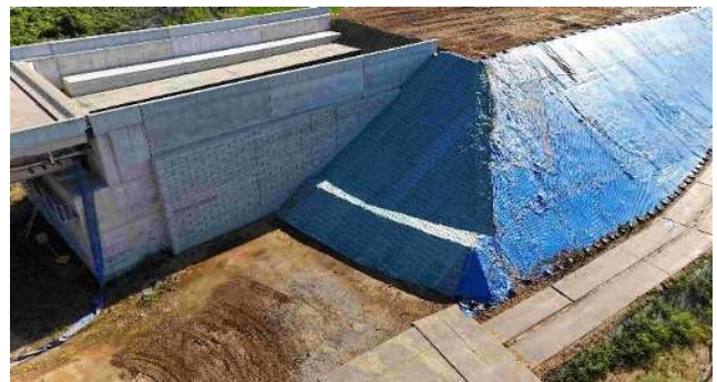
<完成(潮来佐原線橋背面軽量盛土工)>
