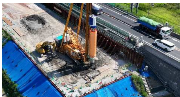
<地盤改良施工状況>
