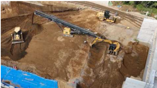
<盛土施工状況>
