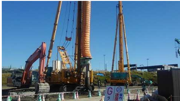
<地盤改良施工状況>
