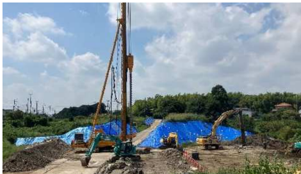
＜地盤改良施工状況＞
