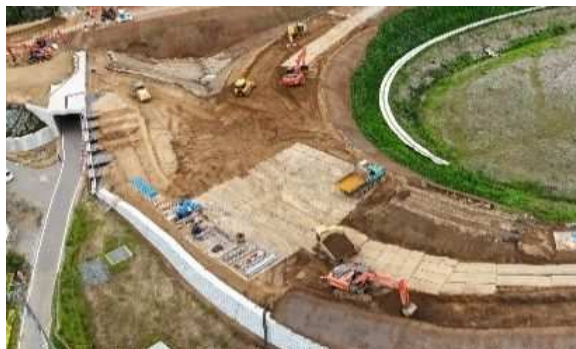
<施工状況(エランプ：盛土、擁壁工など)>
