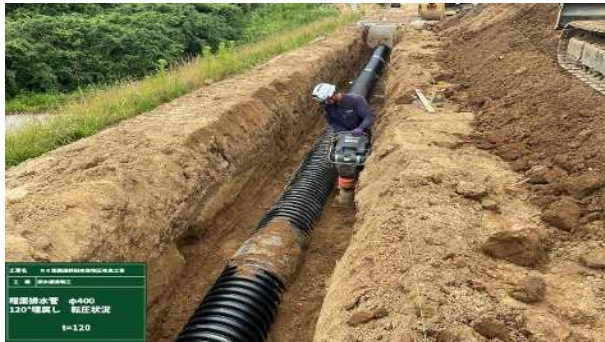
＜縦断管施工状況＞
