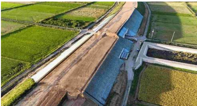
<完成(路体盛土、法面工)>
