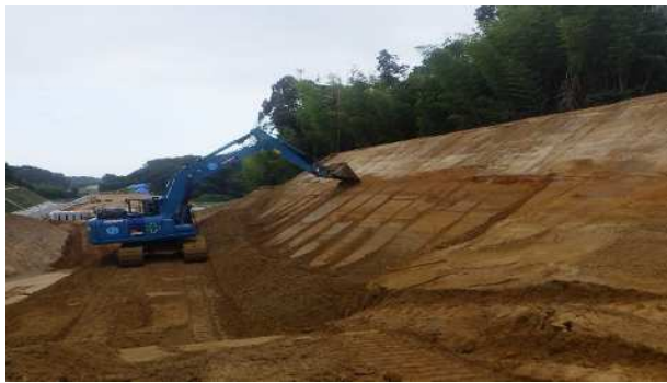
＜切土施工状況＞
