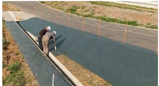
＜防草シート設置状況＞
