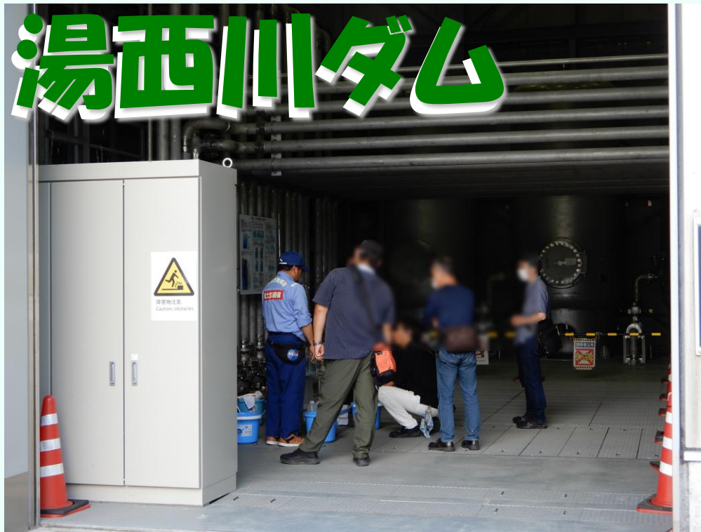
ダムの内部を知る
