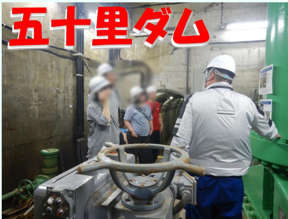
ダムの内部を知る
