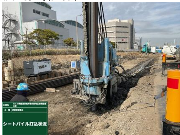
【鋼矢板の圧入】
