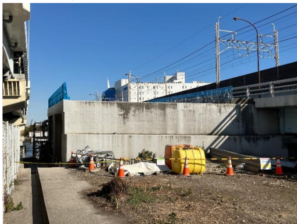
【A1 橋台 施工中】
