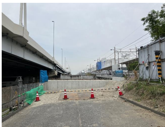
【A0 橋台 施工中】
