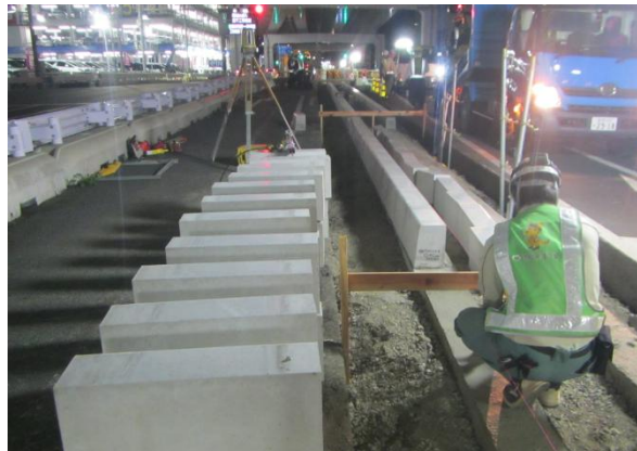
【R16 号夜間規制状況】
