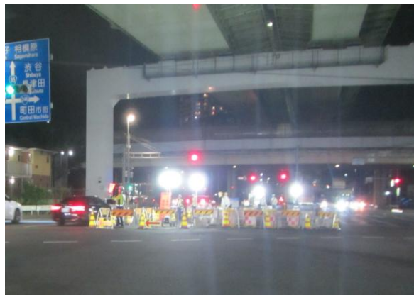
【R16 号夜間規制状況】
