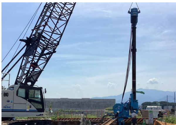
【硬質地盤専用圧入機による施工状況】
