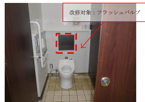
改修対象衛生設備
