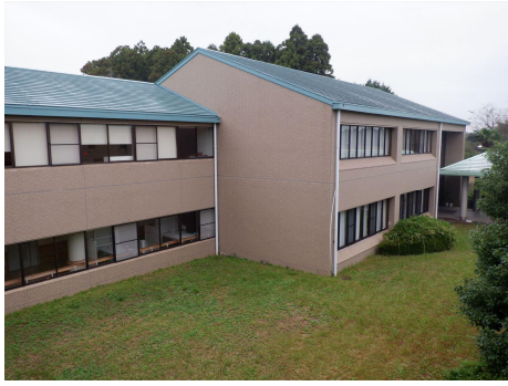
① 厚生棟外観
