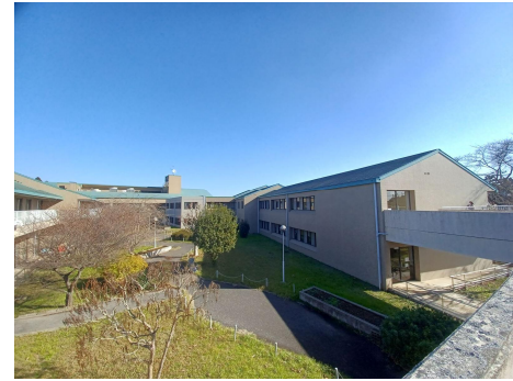
④ C棟外観
