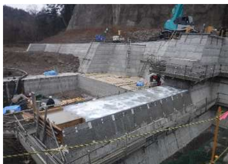
<床固工 コンクリート打設状況>
