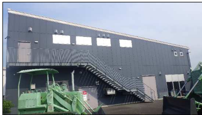
庁舎外観（西面外壁）
