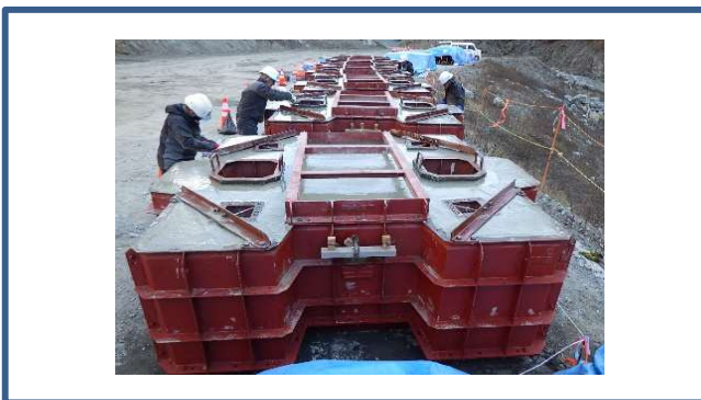
<写真1 根固ブロック製作工施工状況>
