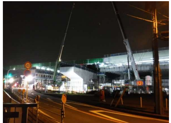
<写真2 施工状況>
