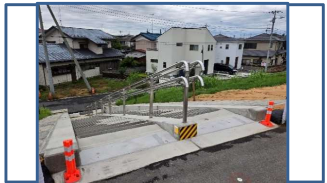
<写真2 階段の補修>
