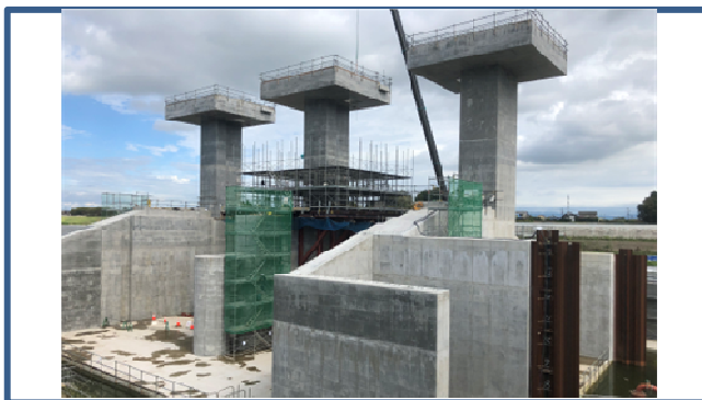
門柱・操作台・翼壁 施工状況
