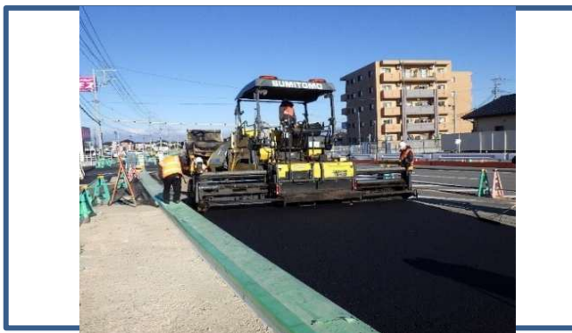
<写真1 舗装施工状況>
