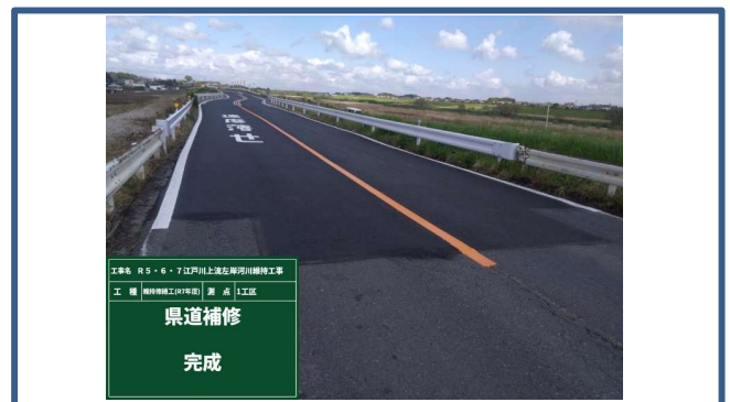
<緊急道路補修完成>
