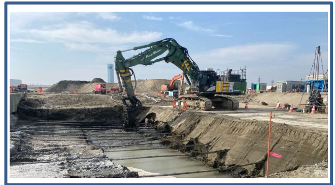
<写真2 中層混合処理工>
