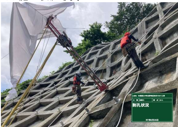
<写真1 鉄筋挿入工(施工状況)>
