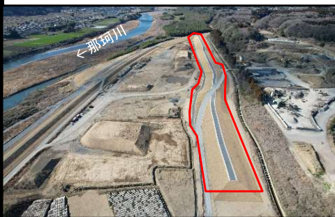
＜写真1 周囲堤築堤＞
