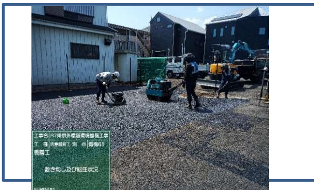
<写真1 防塵舗装施工状況>
