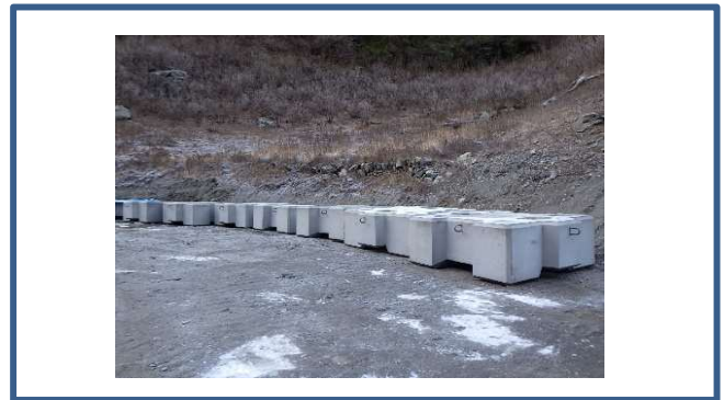
<写真2 根固ブロック製作工完了>
