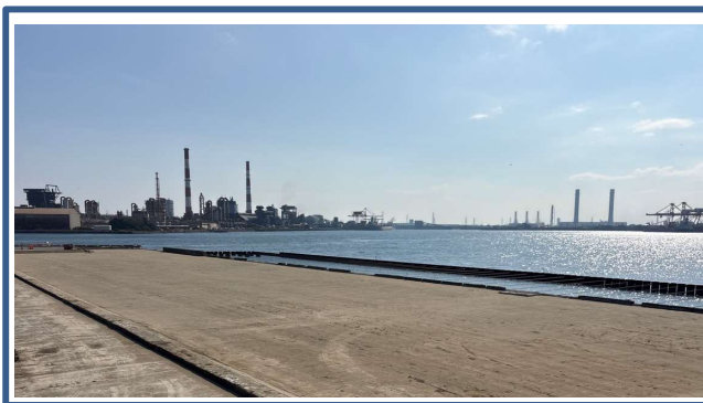
<写真1 工事完成>
