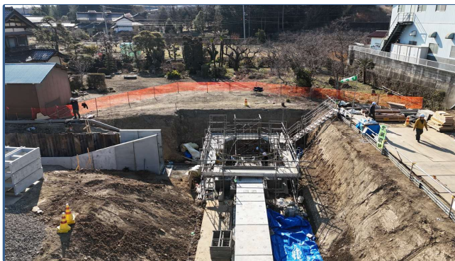
<民地との近接施工状況>
