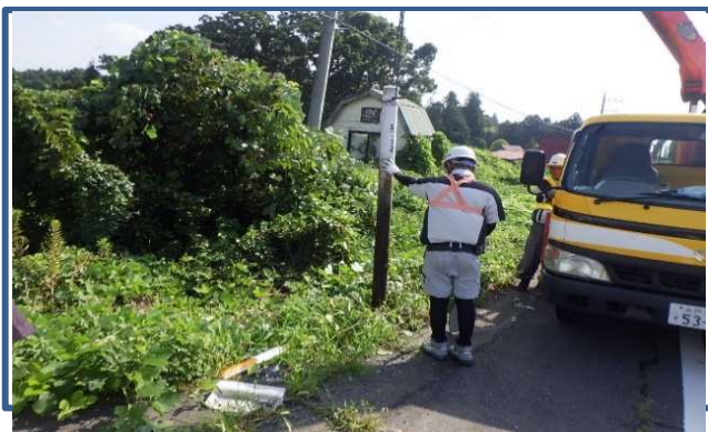
<防護柵施工状況>
