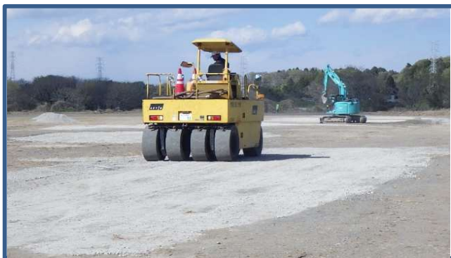
駐車場施工状況
