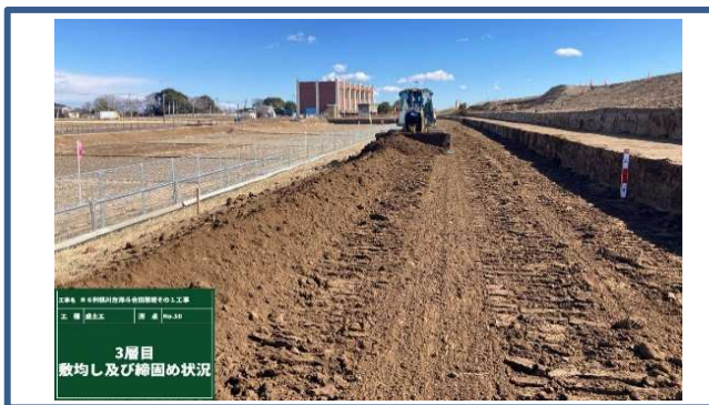
<盛土施工状況>
