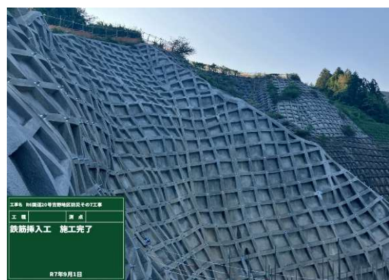
<写真2 鉄筋挿入工(完成)>
