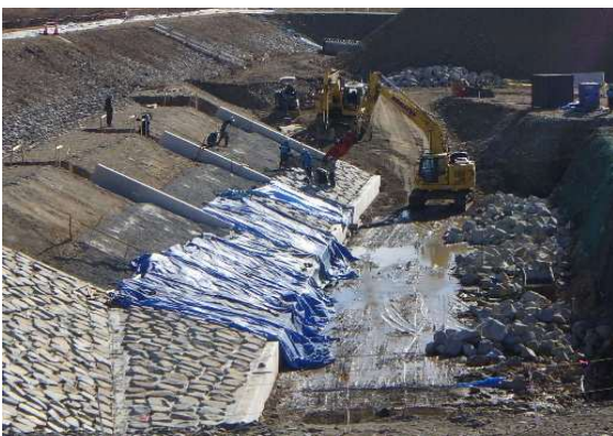
<写真1 護岸工施工状況>
