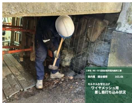
橋梁補修状況
