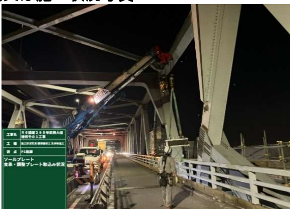
< 支承搬入状況 >
