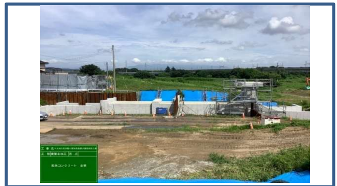
樋管本体コンクリート全景(築堤工施工前)
