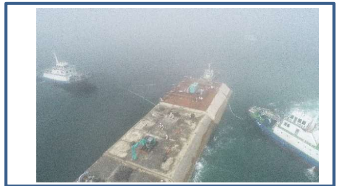
<ケーソン据付状況>
