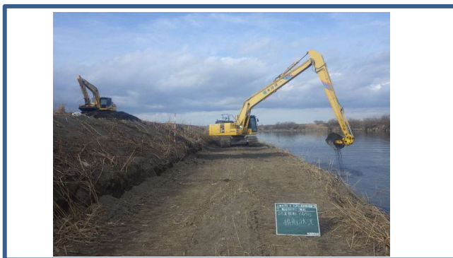
<河道掘削施工状況>
