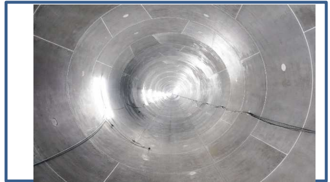
＜写真2 シールドトンネル完成＞
