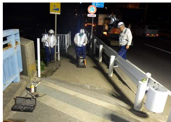
＜歩道段差補修作業＞
