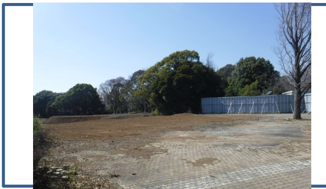
<写真1 昭島管理等解体>
