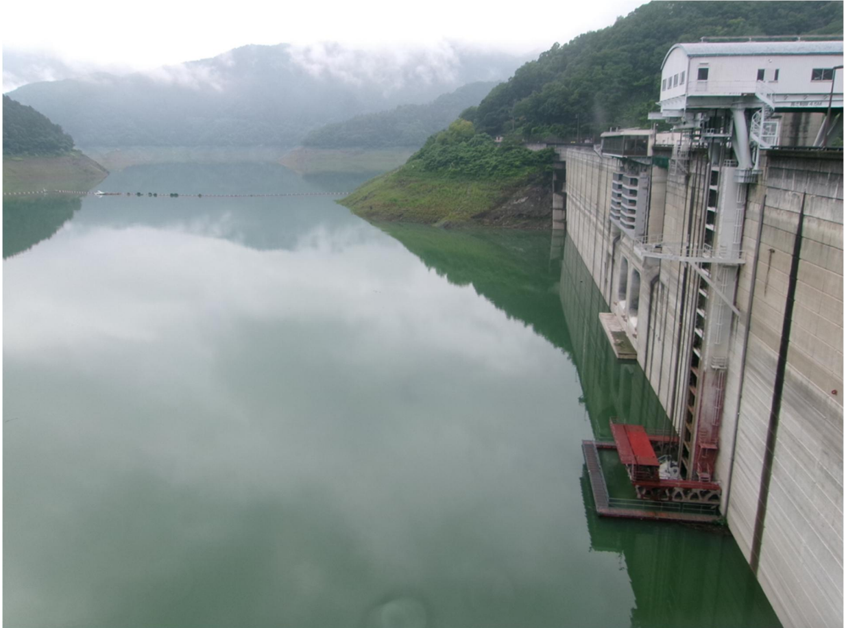
下久保ダムの貯水状況（令和8年7月6日撮影）
