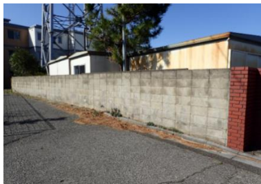
既存コンクリートブロック塀（南西側）
