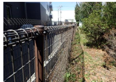
フェンス改修済（南東側）
