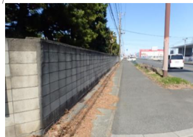
既存コンクリートブロック塀（東側）
