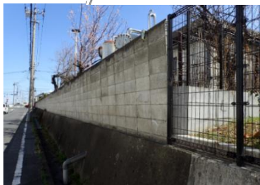
既存コンクリートブロック塀（北西側）
