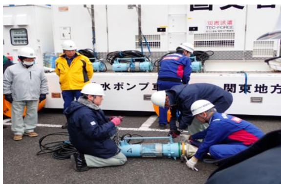
排水ポンプの展開・組立（イメージ）
