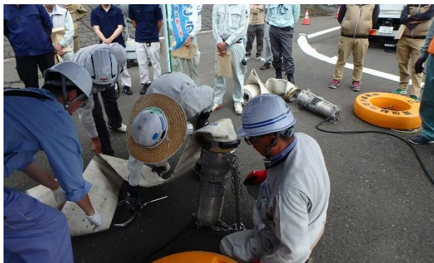
排水ポンプの組立訓練
