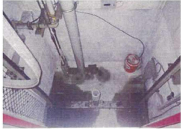
既存エレベーターシャフト内1
