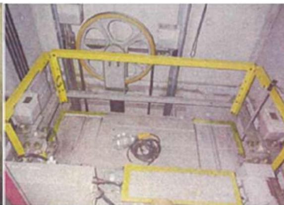
既存エレベーターシャフト内2
