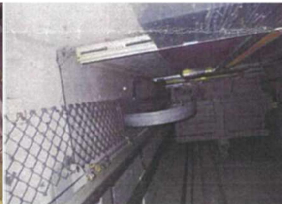
既存エレベーターシャフト内3
