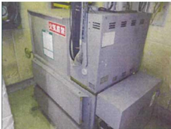
①既存油圧エレベーター機械室
