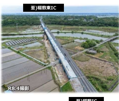
【稲敷IC～稲敷東IC間】写真④ ※上部工工事・舗装工事 施工中
