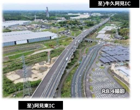
【牛久阿見IC～阿見東IC間】写真③ ※舗装工事 施工中
