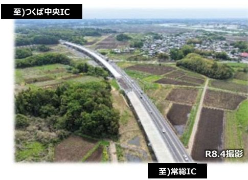
【常総IC～つくば中央IC間】写真② ※舗装工事 施工中
