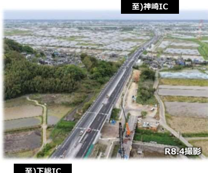
【神崎IC～下総IC間】写真⑤ ※舗装工事 施工中
