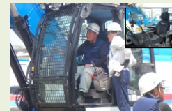
ICT建設機械による施工実習
