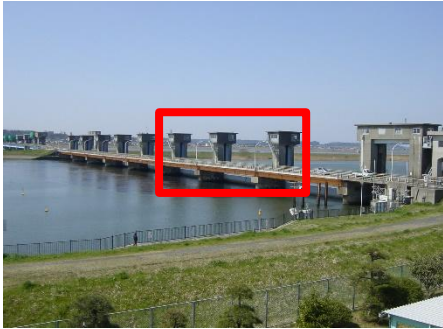
常陸川水門全景
