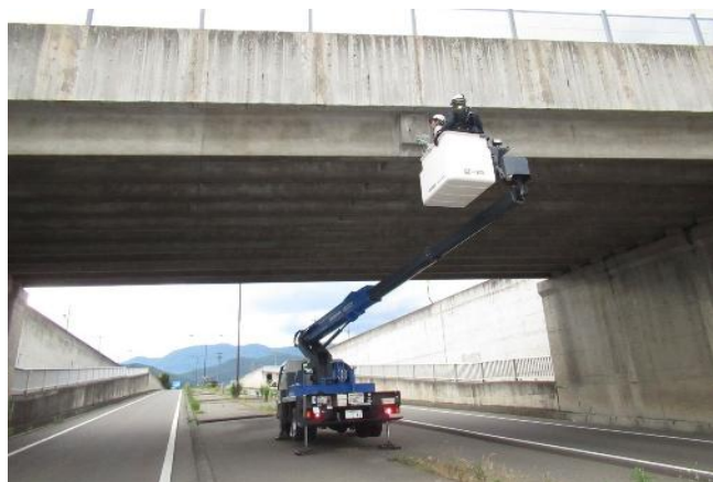
(鉄道高架橋の点検 (例))
