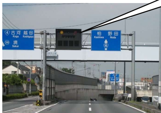
②電光掲示板(地下道手前の情報提供)
