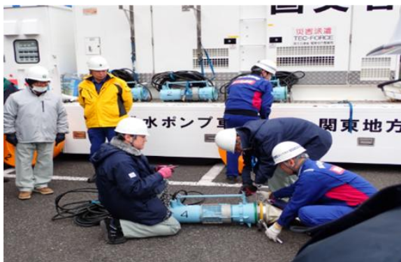
排水ポンプの展開・組立（イメージ）
