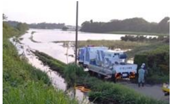
令和5年台風第13号における排水ポンプ車作業状況 （千葉県茂原市御蔵芝付近）
