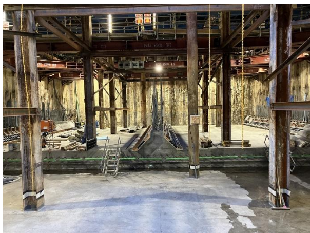
○函渠工<底版Co打設>
