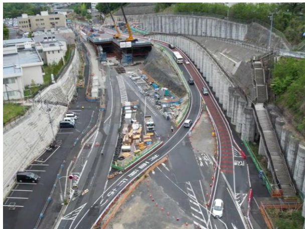
○トンネル終点側全景
