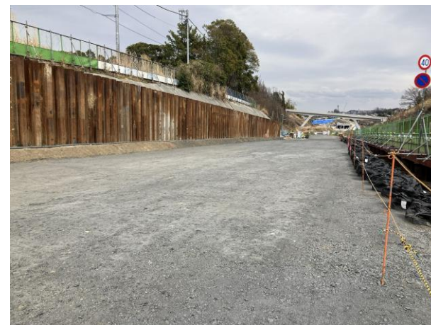
○埋戻し工<埋戻し完了>
