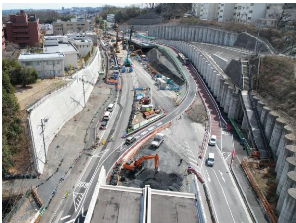
○トンネル終点側全景
