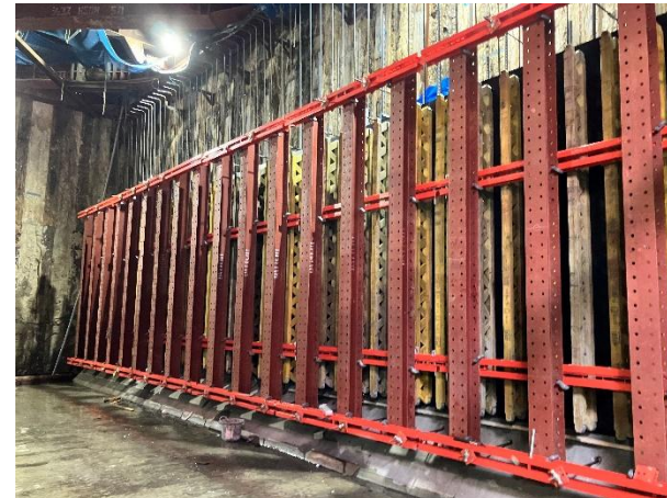
○函渠工<側壁部型枠組立>
