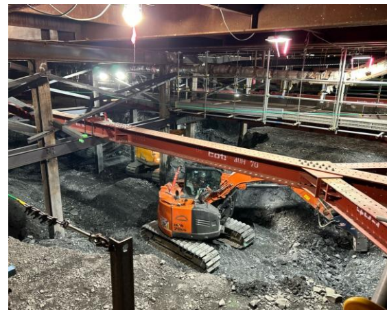
○下り線 掘削状況
