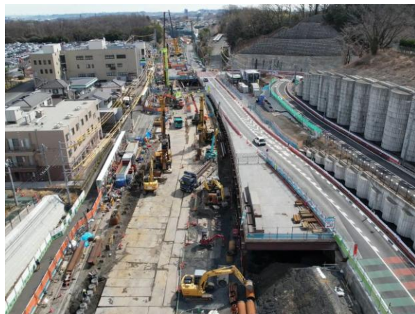
○上り線土留め杭打設状況
