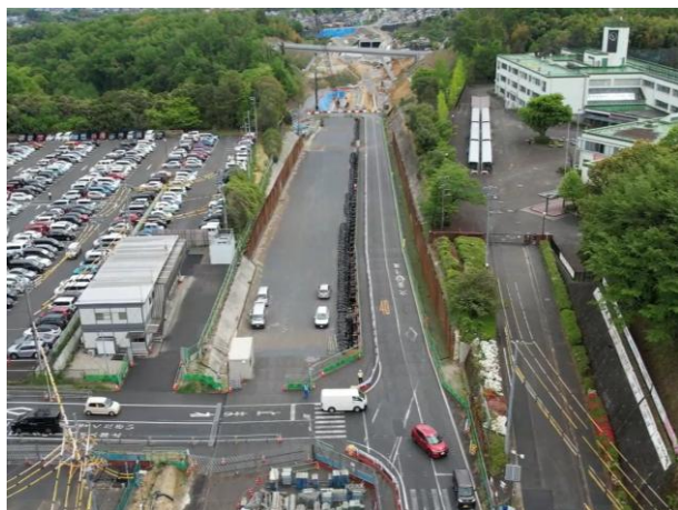
○トンネル起点側全景
