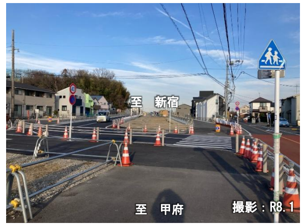
写真② 川辺堀之内地区改良工
