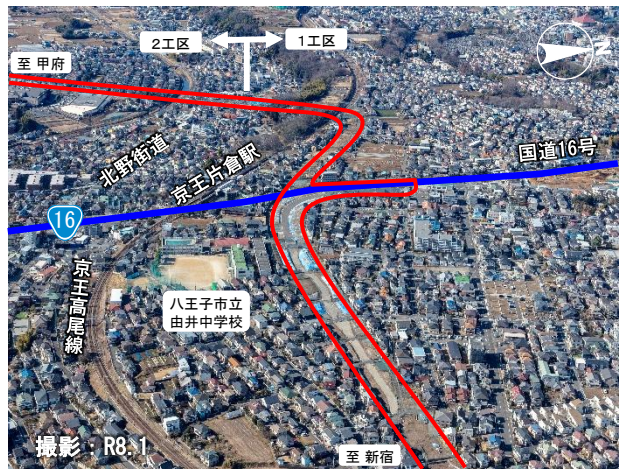
写真① 新宿方向から国道16号ランプ部を望む
