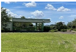
老朽化した野外劇場と広場
