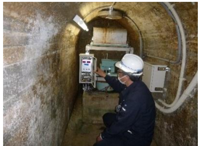
ダム管理設備の点検
