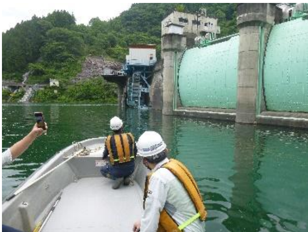
ダム貯水池内の巡視
