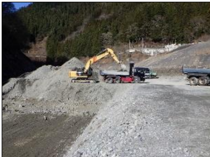
堆積土砂の掘削状況
