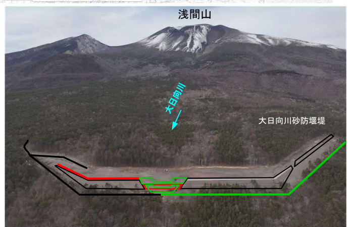
大日向川砂防堰堤（施工中）
