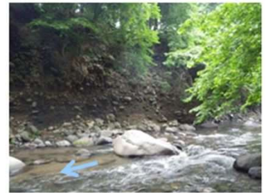
溪岸浸食状況
