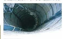
集水井工内部
