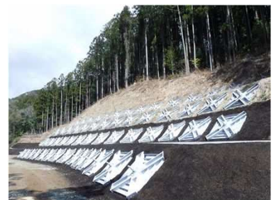
対策工(アンカー工)
