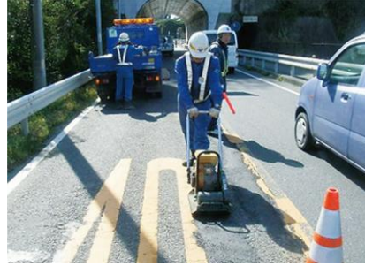
早期に対応が必要な箇所に対する応急維持（路面補修）
