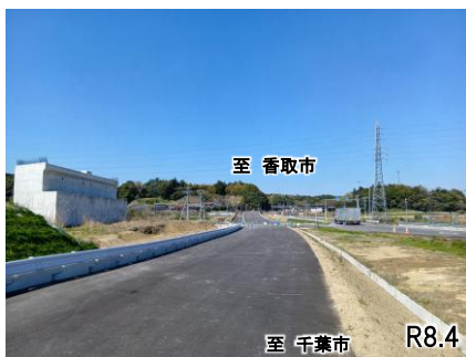
成田拡幅(東金山橋付近の改良工事)
