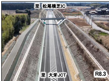
写真① 多古地区改良工事
