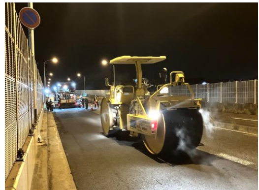
舗装修繕工事の様子
