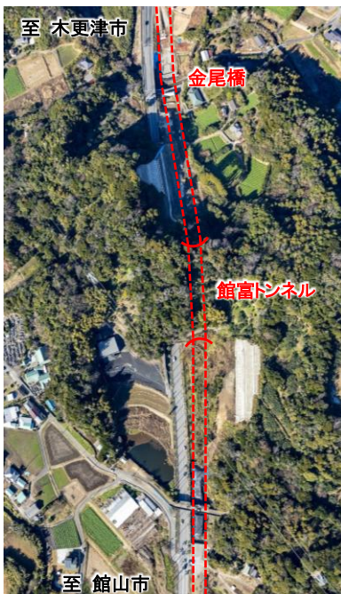
工事の実施状況(川名富浦地区)
