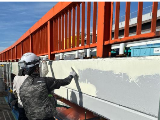
橋梁修繕工事の様子
