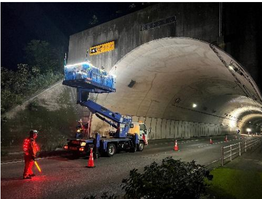
トンネル点検の様子
