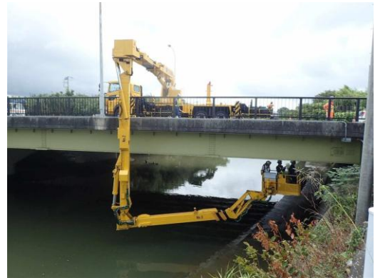
橋梁点検の様子
