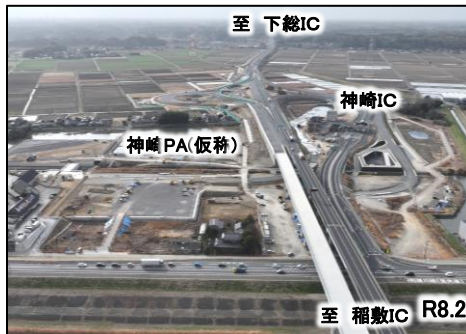
写真② 神崎PA(仮称)工事
