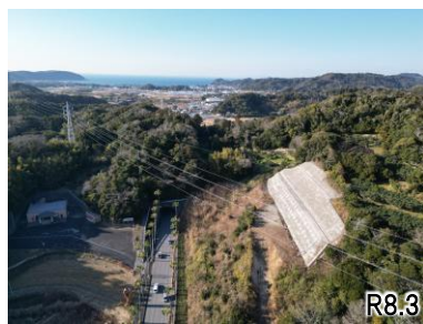
(川名地区 施工状況)
