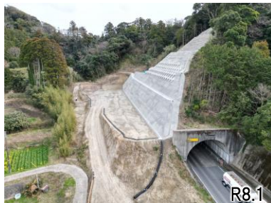
(富浦地区 施工完了)
