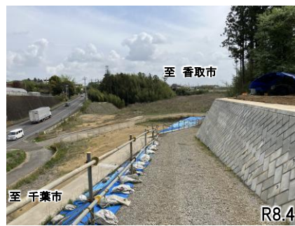
大栄拡幅(桜田地区の改良工事)
