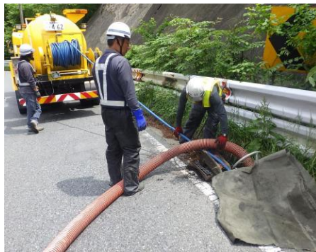
道路清掃状況
