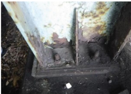
— 渋川上白井綾戸（柱基部補修） —
