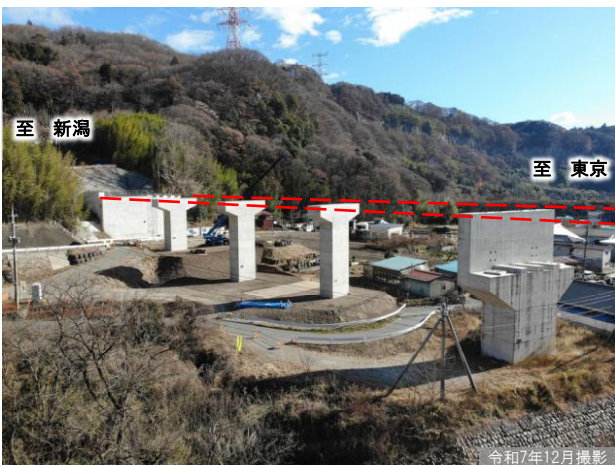
① 綾戸第一橋の橋梁下部工事施工状況
