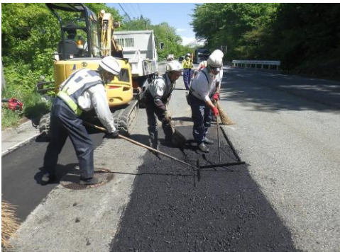
舗装補修状況
