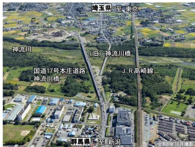
神流川橋付近の状況
