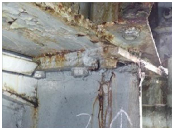
— 渋川上白井綾戸（横梁部補修） —
