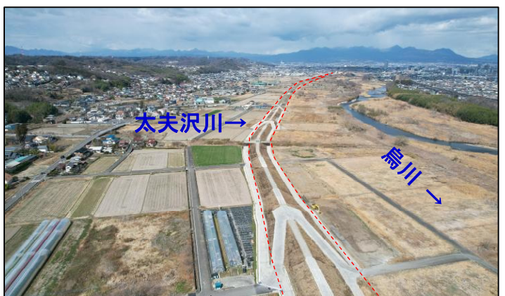
烏川上流築堤事業の堤防整備状況(根小屋町 太夫沢川付近)
