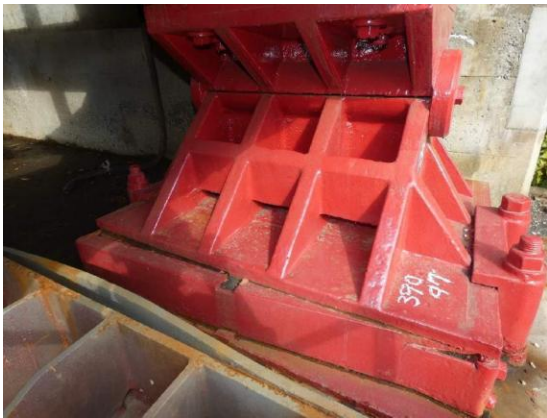
— 新三国大橋（支承補修） —
