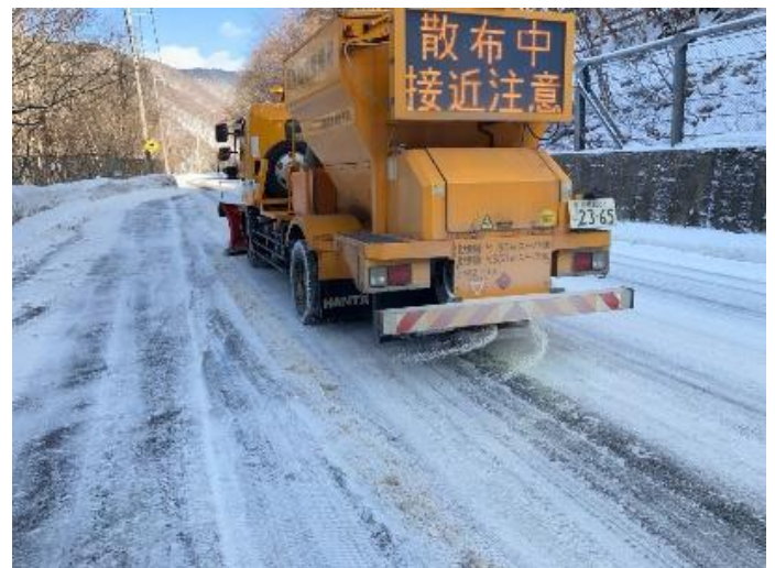
凍結防止剤散布状況
