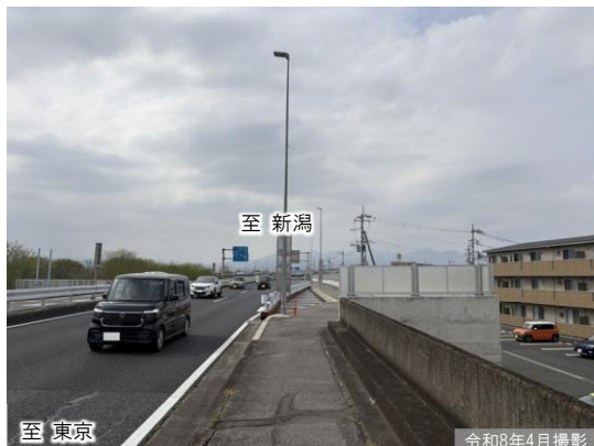
① 拡幅区間の交通状況
