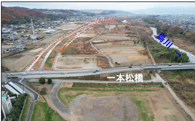
烏川上流築堤事業の堤防整備状況(根小屋町 一本松橋付近)
