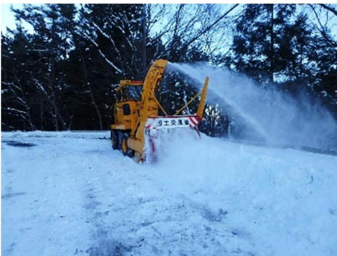
除雪作業状況
