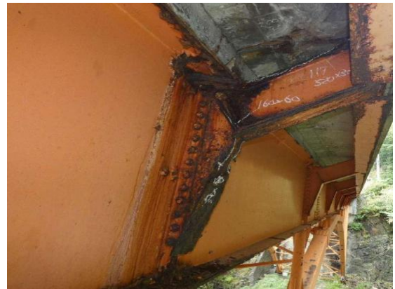
— 法師大橋（横桁ブラケット補修） —
