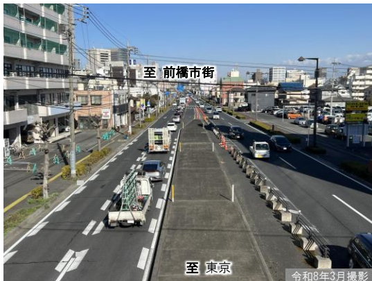
①桃井虹色橋から前橋市街地方面の状況
