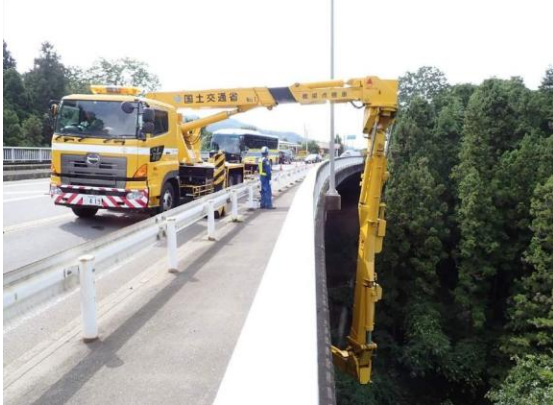
橋梁点検車による点検状況（湯舟橋）
