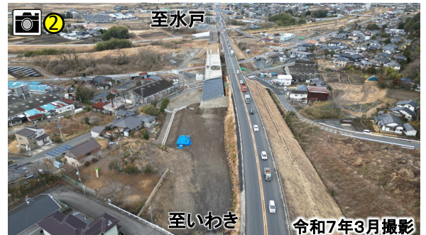
石名坂橋付近の工事状況
