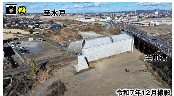
玉戸跨線橋の工事状況
