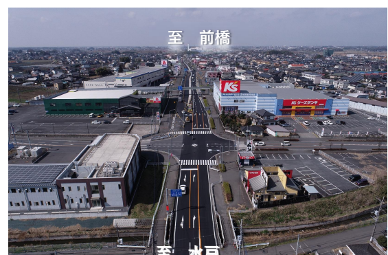
② 水戸方向から前橋方向を望む
