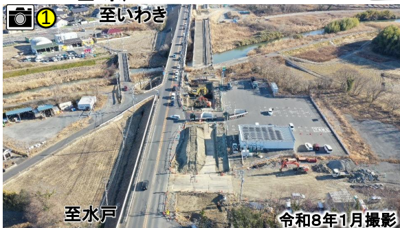
茂宮川橋付近の工事状況
