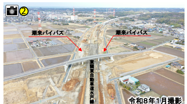
小泉南地区の工事状況
