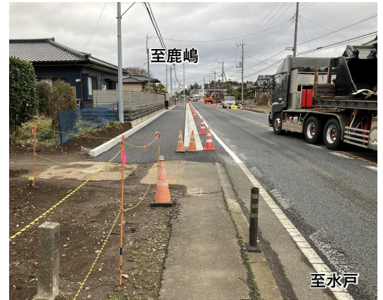
歩道拡幅の工事状況
