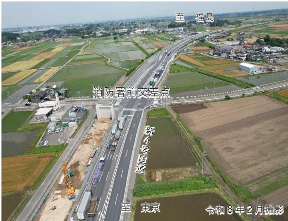
もとくりはし ①元栗橋跨道橋(消防署前交差点)付近
