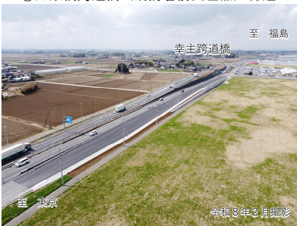
こうしゅ ②幸主跨道橋付近
