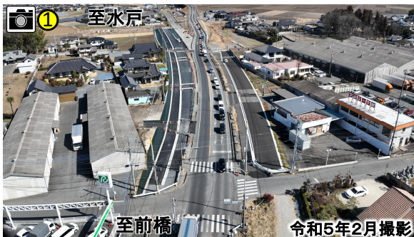
玉戸交差点付近の工事状況
