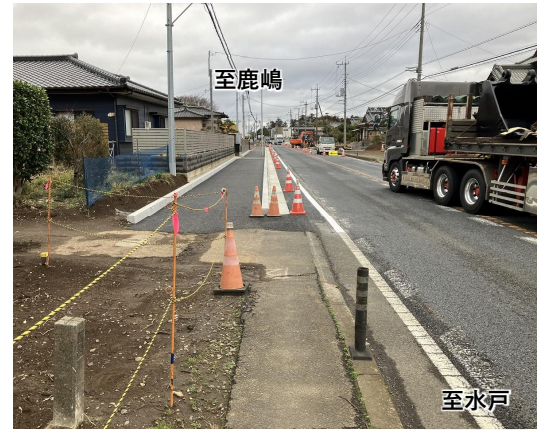
歩道拡幅の工事状況
