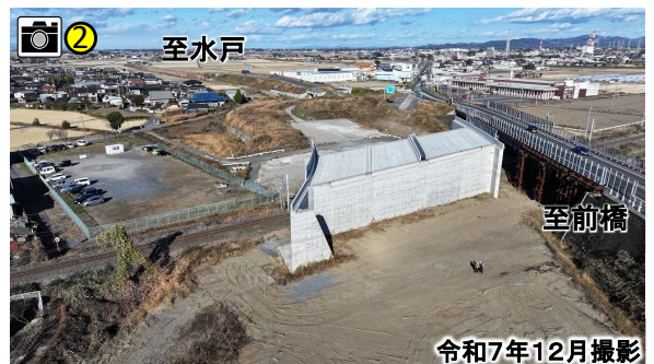
玉戸跨線橋の工事状況
