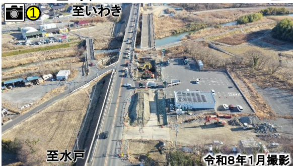
茂宮川橋付近の工事状況
