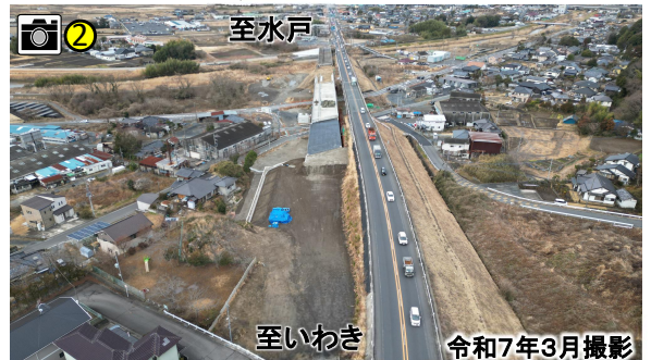
石名坂橋付近の工事状況
