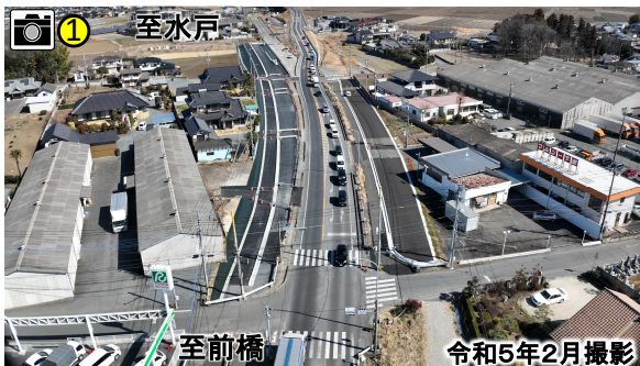
玉戸交差点付近の工事状況
