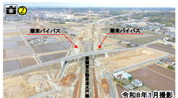
小泉南地区の工事状況
