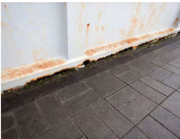
・地覆の腐食 <地覆補修>
