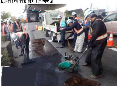
【路面補修作業】
