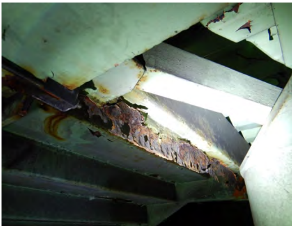
・地覆の腐食 <地覆補修>
