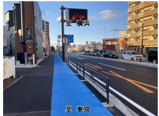
【歩道整備後の状況】 歩道拡幅による歩行者と自転車走行空間の分離 (川崎市幸区神明町下り線)
