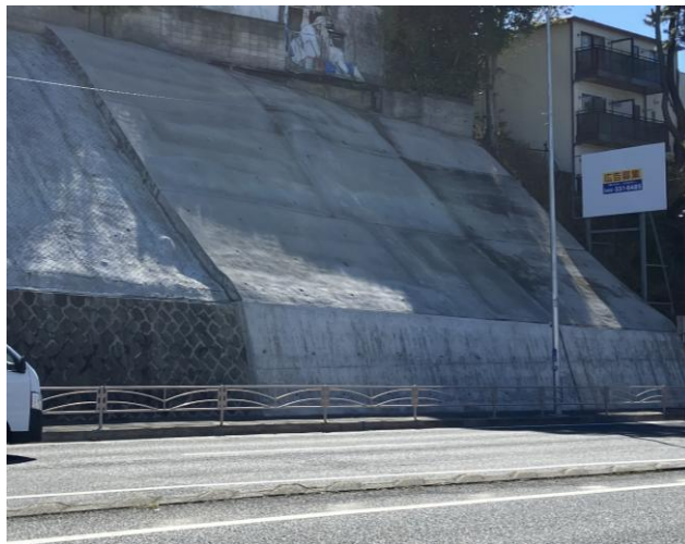
【市街地部の法面对策】 国道1号 横浜市鶴見区 コンクリート吹きつけによる法面对策
