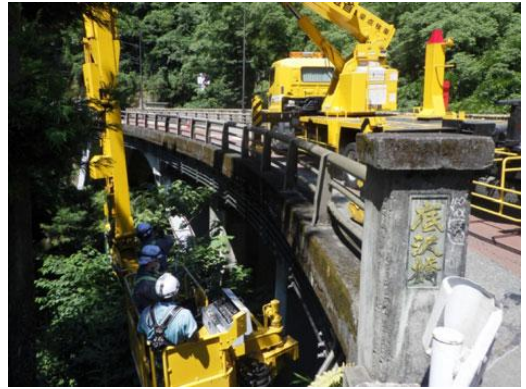
【国道20号 橋梁点検車による橋梁点検事例】
