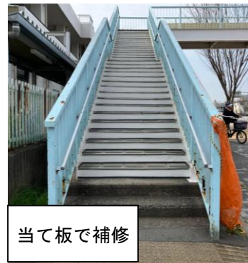
【国道16号 相模原市清新三丁目歩道橋における階段部補修事例】
