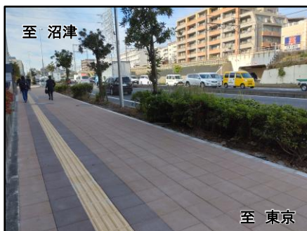
①整備後の市ヶ尾地区(拡幅部)
