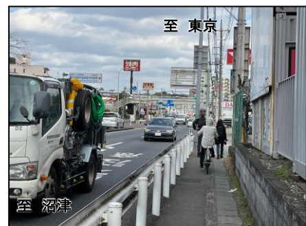
②整備前の新石川地区(拡幅部)
