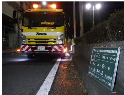
清掃 (路面清掃・排水施設清掃等)
