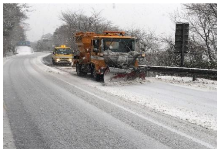
除雪作業 (国道1号箱根新道)
