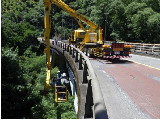
【国道20号 橋梁点検車による橋梁点検事例】
