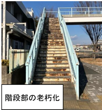
【国道16号 相模原市清新三丁目歩道橋における階段部補修事例】
