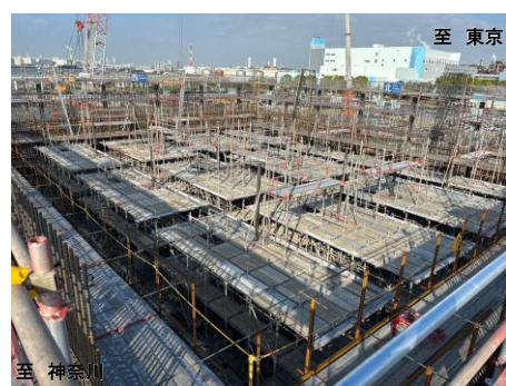
②【多摩川トンネル浮島立坑(令和8年4月撮影)】
