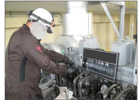
機械設備の点検
