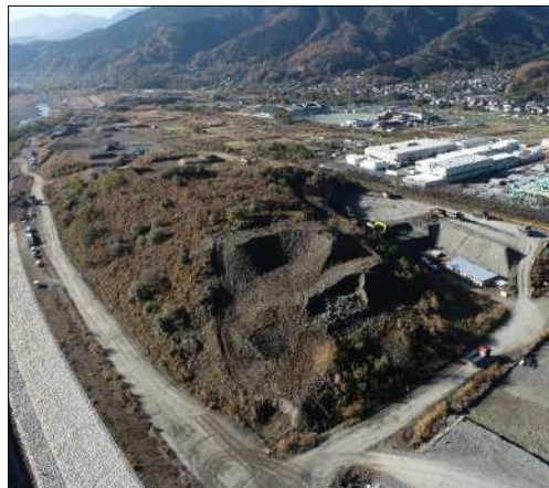
下山地区(トンネル残土仮置き場)
