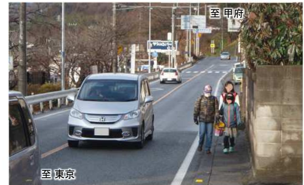
③ 現在の国道20号の状況
