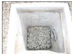
雨水貯留浸透枡整備事例(昭和町)
