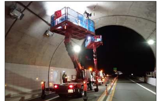
トンネル点検
