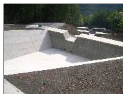
塩島沢堰堤群(富士川砂防事務所)
