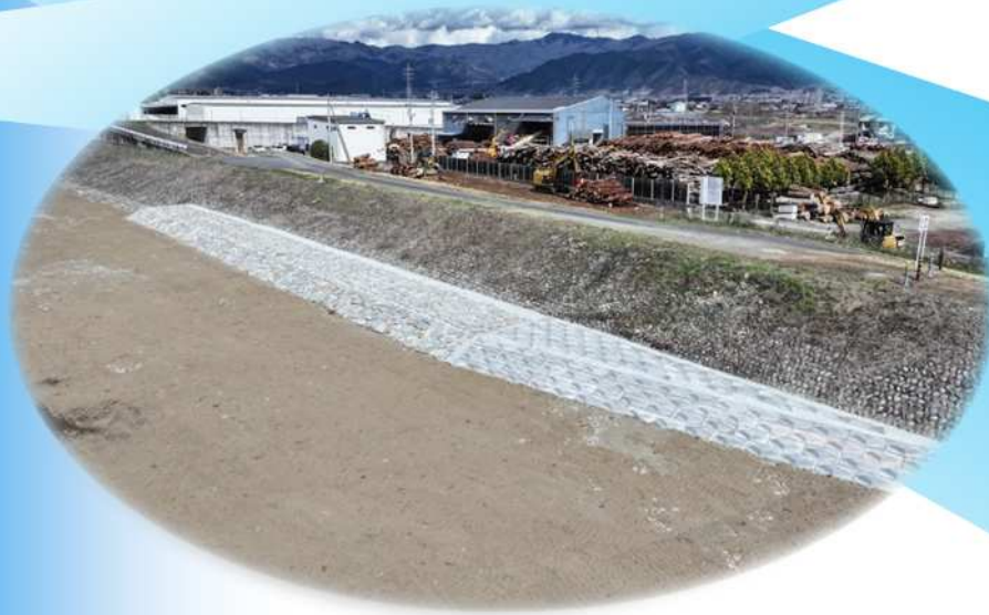
笛吹川 大野地区護岸整備
