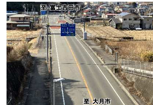
開通状況(都留市玉川地区)
