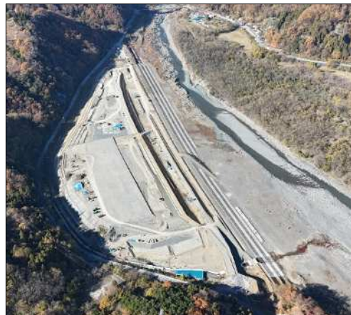
栗倉地区(トンネル残土造成地)
