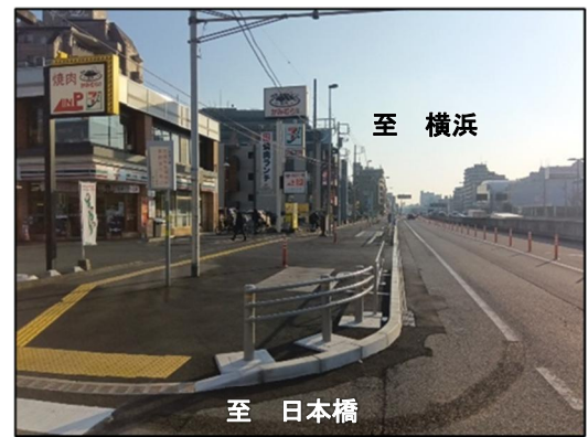
②歩道部拡幅状況 (令和8年2月撮影)
