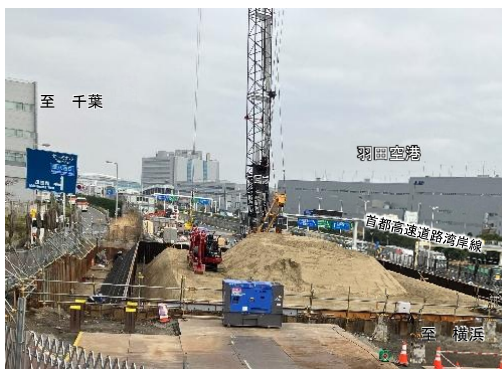
①多摩川トンネル羽田立坑（令和8年4月撮影）
