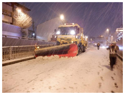
除雪作業 (国道246号世田谷区瀬田)
