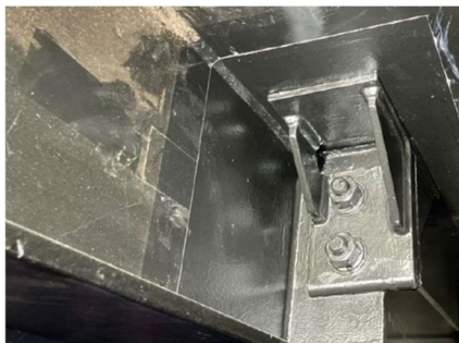
中川大橋のあて板設置状況
