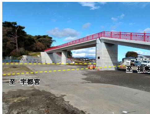
② 三区町地区の施工状況
