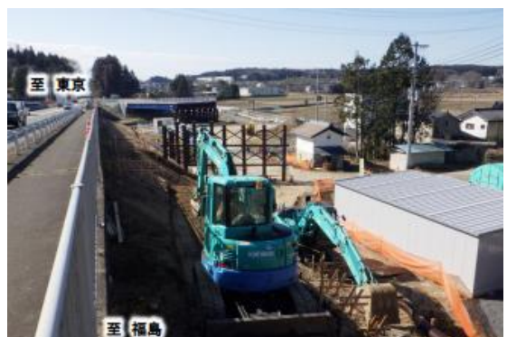
② 前岡地区施工状況（R8年3月撮影）
