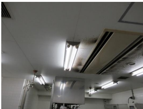
学生棟 洗浄室
