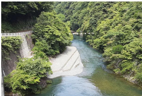
ダム直下流への土砂還元
