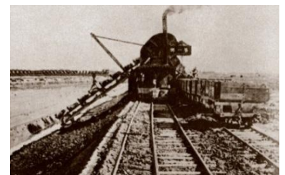
蒸気掘削機による機械掘削の様子
