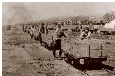
人力掘削の様子（土運搬状況）
