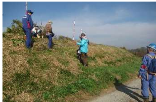
職員による堤防点検
