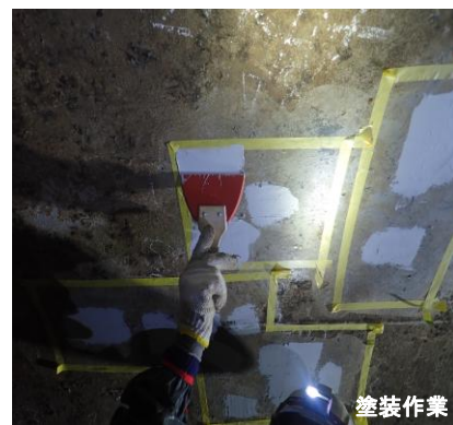
導水管内補修状況
