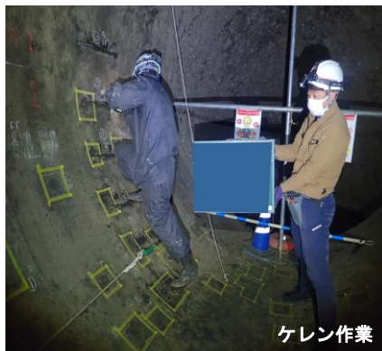
導水管内補修状況
