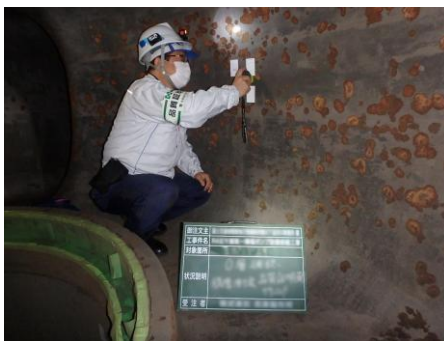
主ポンプ内部点検状況
