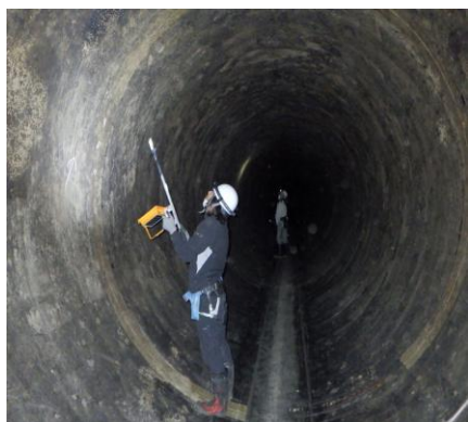
導水管内点検状況
