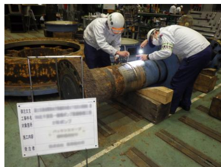
主ポンプ分解補修状況
