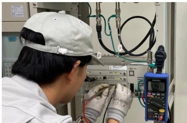
電気通信設備点検状況
