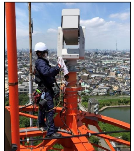
電気・通信設備の点検・整備
