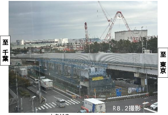
至千葉 至東京 写真 : 塩浜立体区間の施工状況 しおはま R8.2撮影
