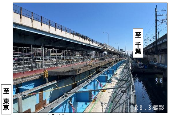
至東京 至千葉 写真 : 末広橋の拡幅工事の施工状況 すえひろ R8.3撮影
