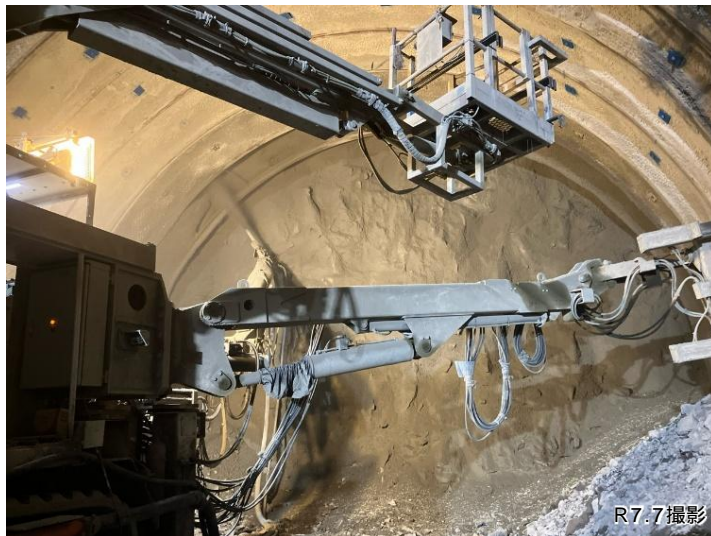
トンネル工事施工状況
