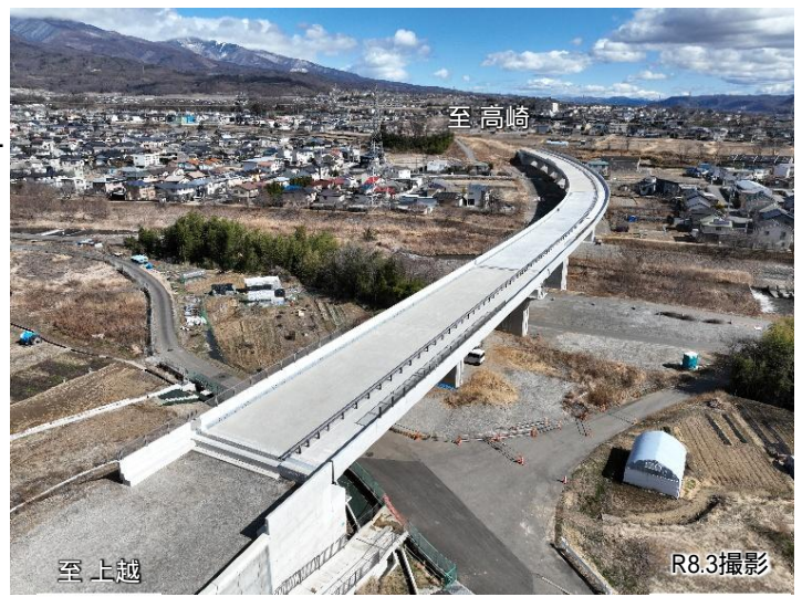
R7年度完成した(仮称)神川橋
