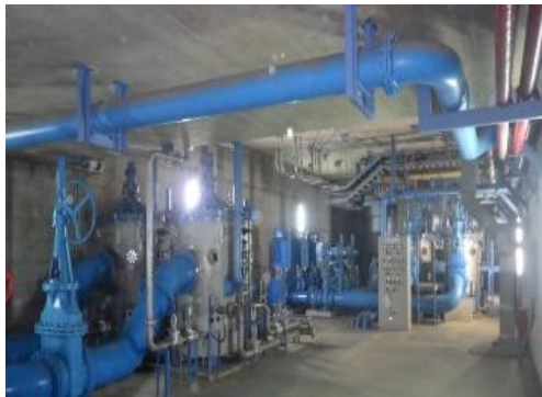
配管等の設備構成が複雑な河川水を使用する方式の冷却水系統を合理化(簡素化)
