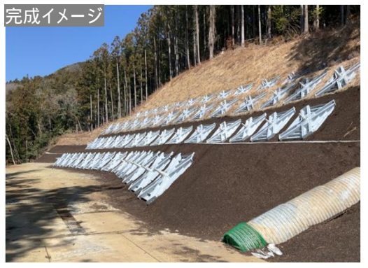
抑止工(アンカー工)
