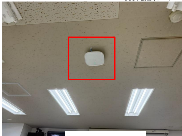
無線LAN設備設置イメージ
