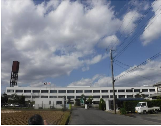
① 敷地出入口
