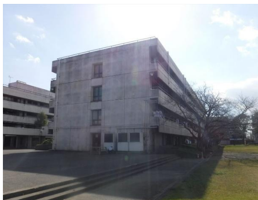
⑦ 外観（生徒寮（1）北面）
