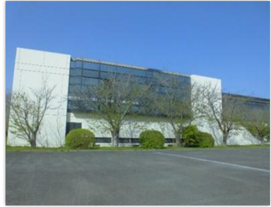
② 外観（道場棟南面）
