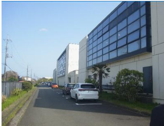
③ 外観（道場棟北面）
